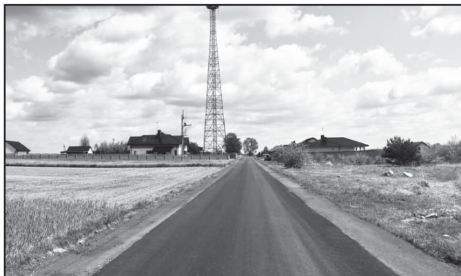
Przebudowana ulica Osiedlowa w Jezierzycach Kościelnych
